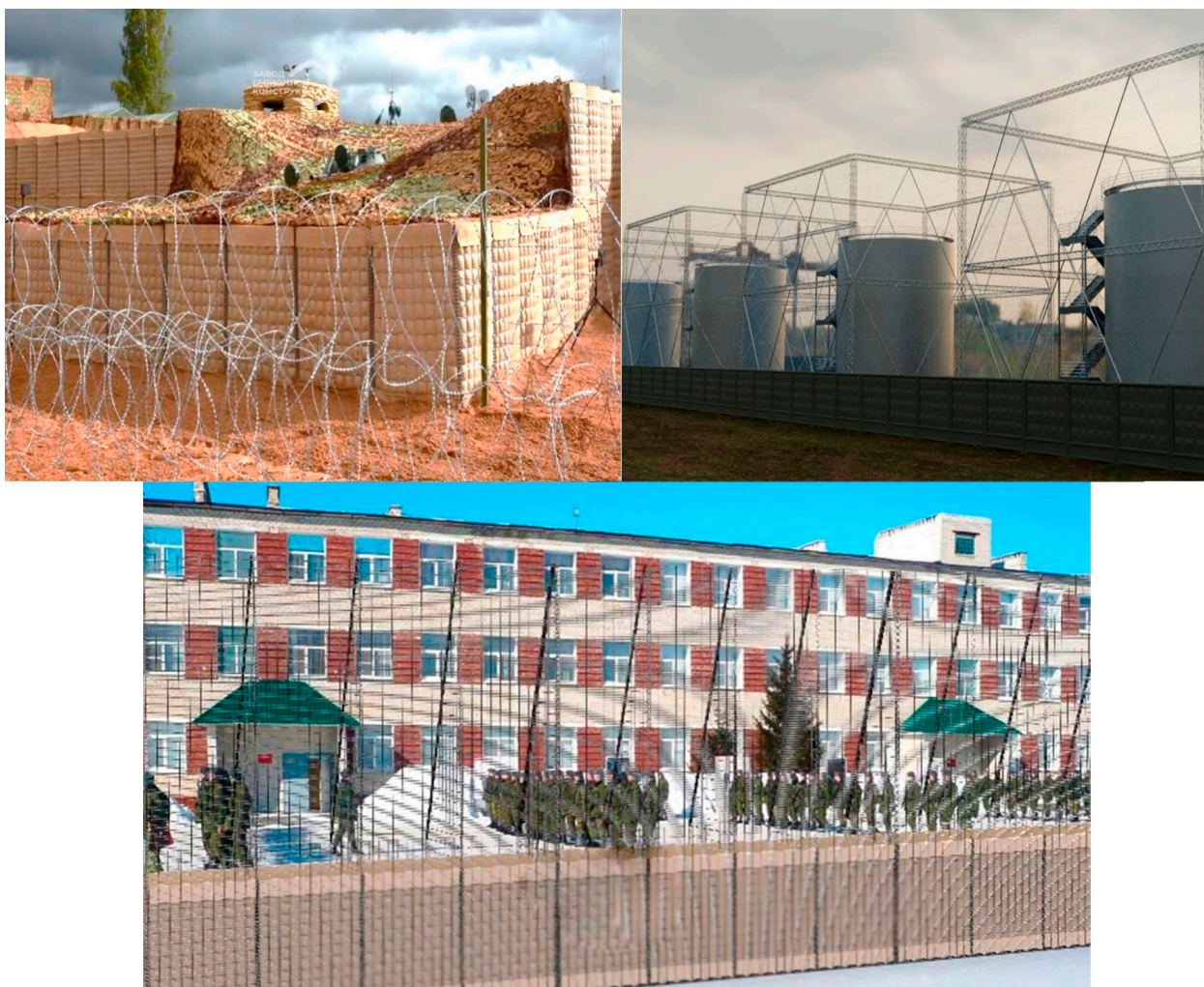
Рисунок 8. Модернизированные системы инженерной защиты
