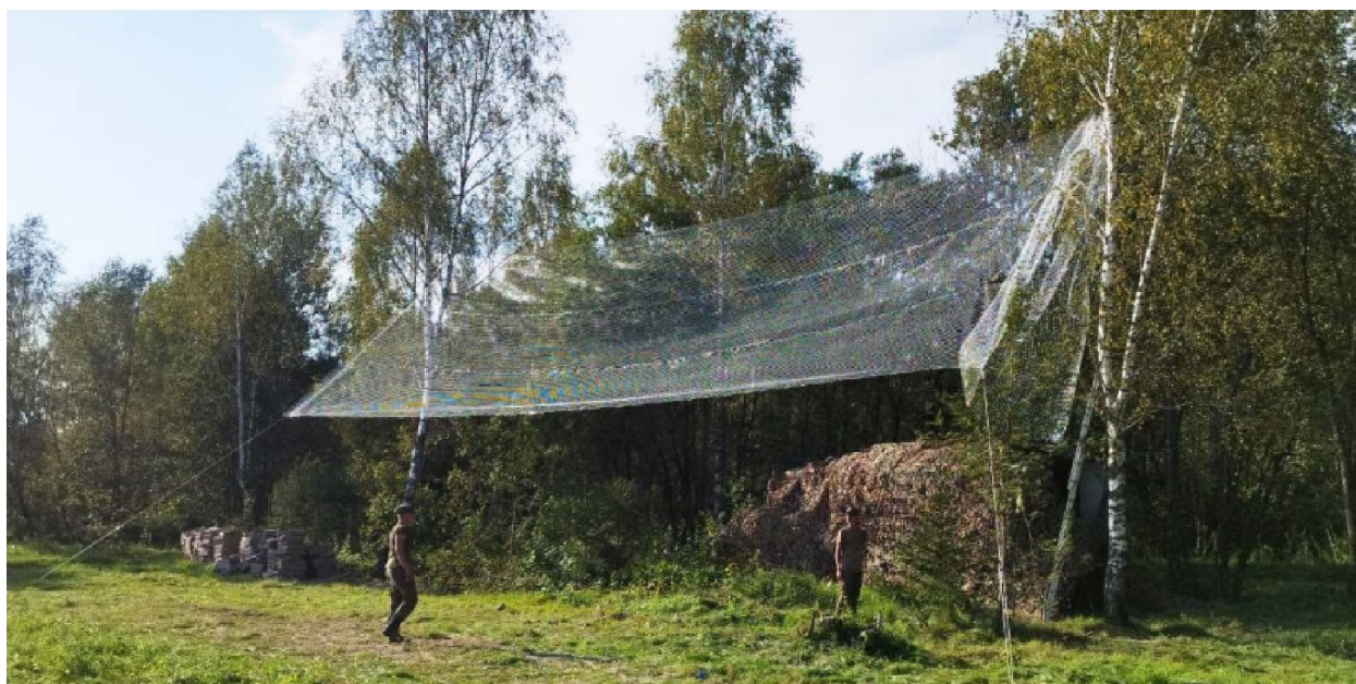
Рисунок 6. Создание безопасной зоны из сетей различного типа
